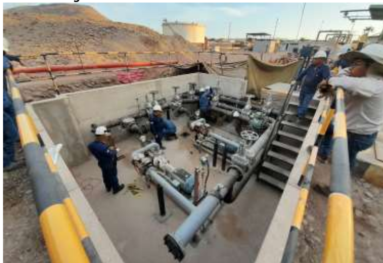
Figura 8. Cámara de bombas booster existentes
