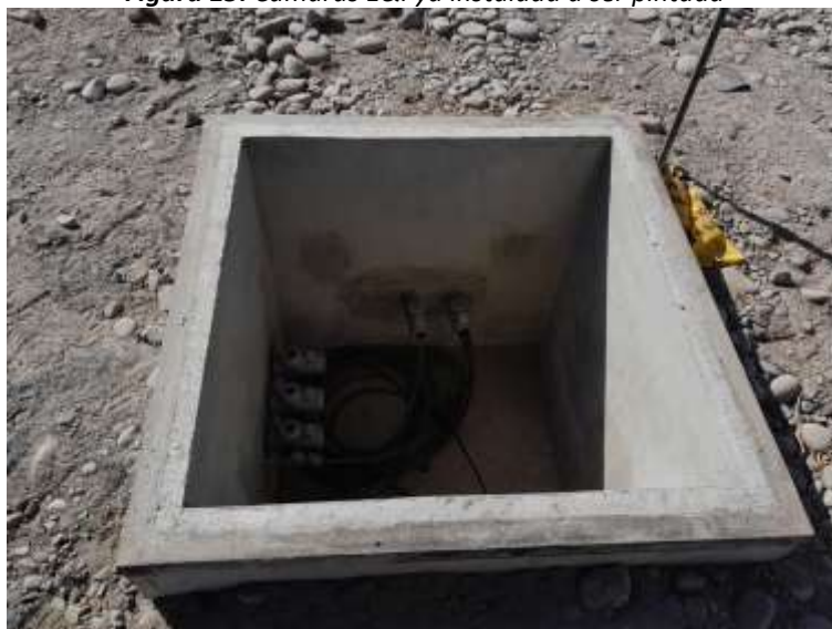
Figura 15. Cámaras E&I ya instalada a ser pintada
