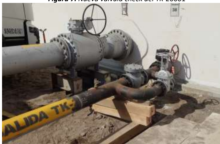
Figura 7. Nueva válvula check del TK-20001
