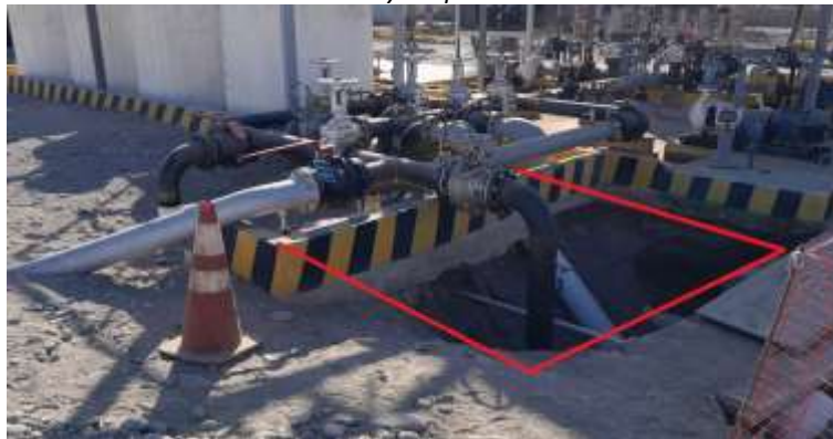
Figura 21. Dique del manifold de llegada de islas tramos a demoler y ampliaciones a realizar
